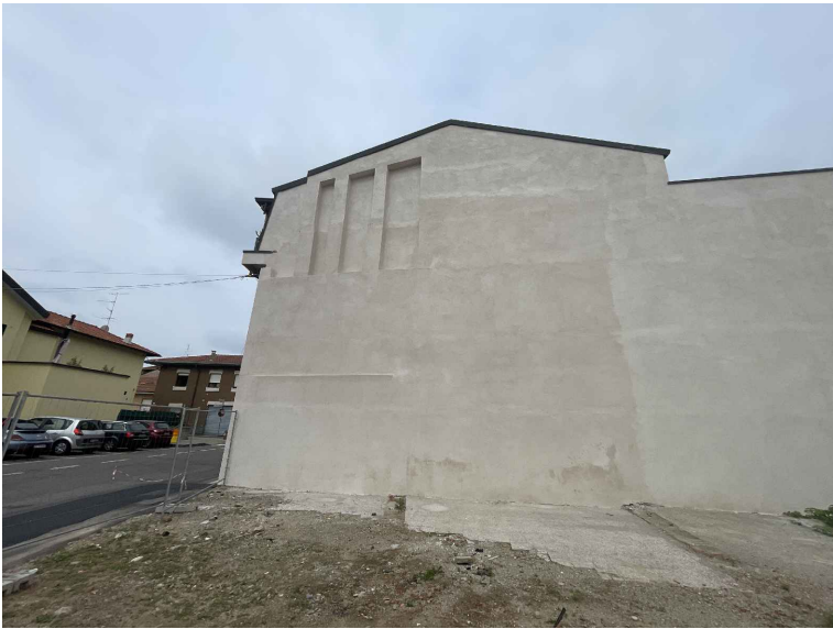
2 Facciata riqualficata dell'edificio all'ingresso - lato ovest
