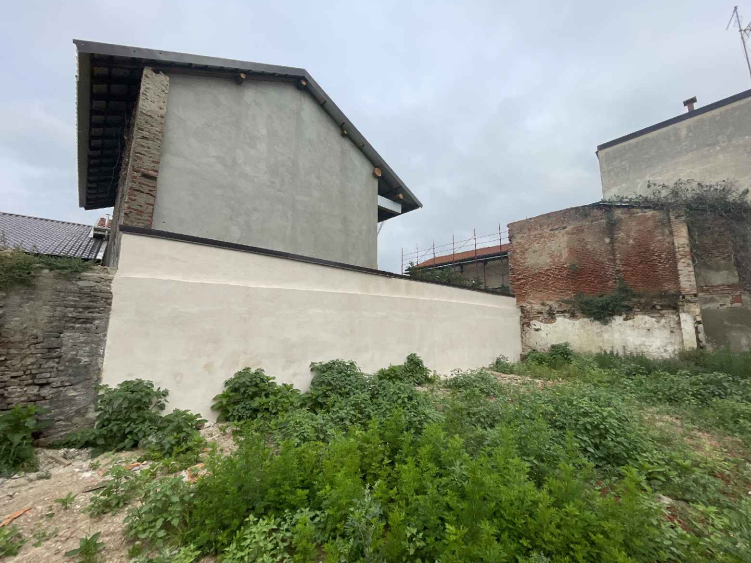
4 Parte delle facciate demolite riqualficate, depositi di macerie ricoperti di vegetazione spontanea
