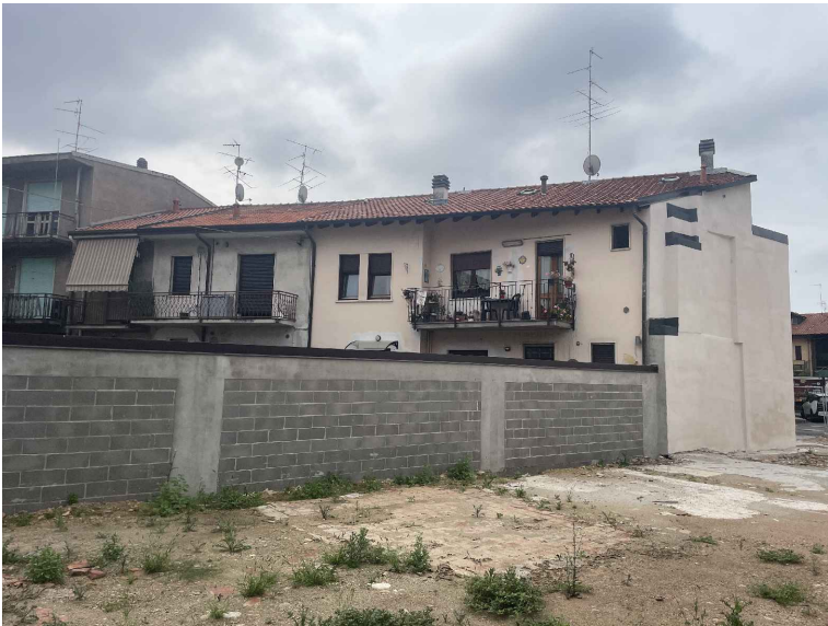
3 Facciata riqualficata dell'edificio all'ingresso - lato est, Nuova recinzione in cls, pavimentazioni e macerie a terra
