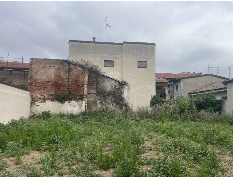
5 Vista del lato nord dell'area di progetto
